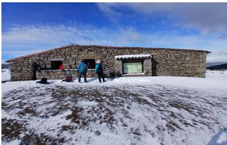
Vista del edificio del Pozo de la Nieve y Refugio
